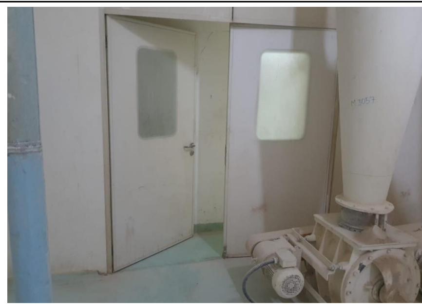
6.8 - FOTO DA SAÍDA DE EMERGÊNCIA
